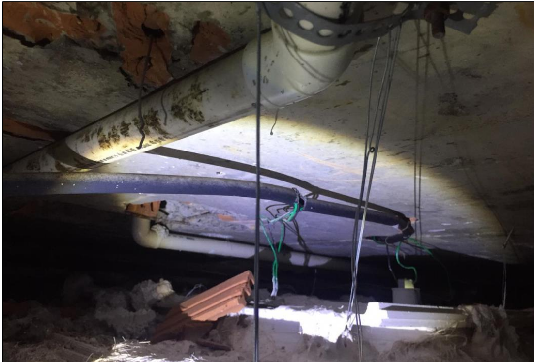
Figura 7. Visão do espaço iluminado por lanterna.
