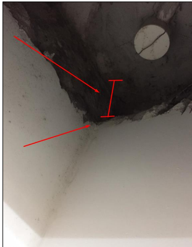
Figura 5. Espaço do local aonde é possível acessar o forro de gesso.
