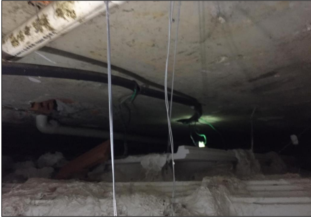
Figura 6. Espaço entre o teto e o gesso.
